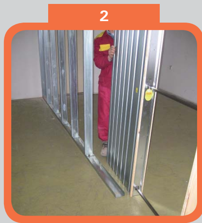
Usazení pouzdra do spodního profilu SDK
