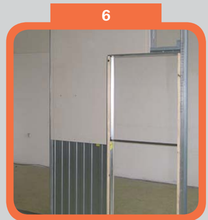
Opláštění pouzdra deskou SDK
