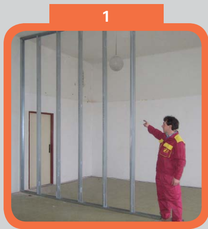
Příprava profilů SDK pro usazení pouzdra
