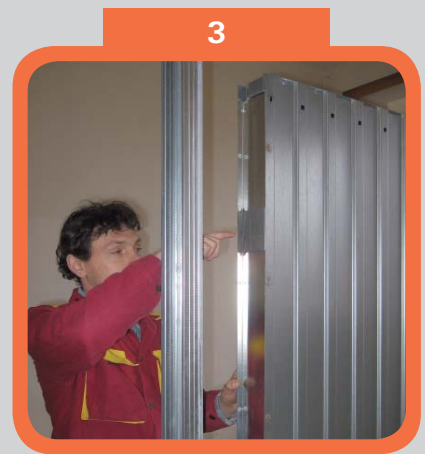
Přípevnění pouzdra ke konstrukci
