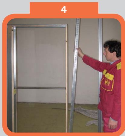
Montáž protilehlé strany konstrukce
