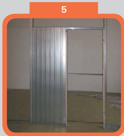
Usazené a zabudované pouzdro v konstrukci
