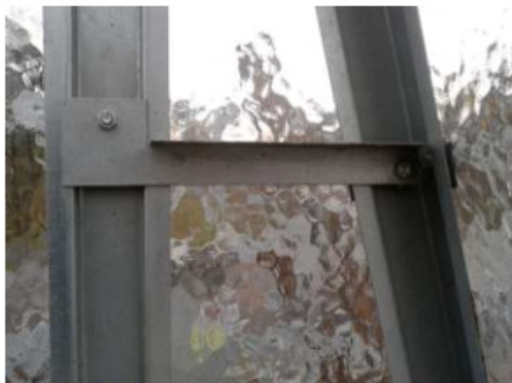
Montáž rohového držáku polic (poz.92) Pomocí šroubů M6 x 25 přimontujeme držáky polic.
