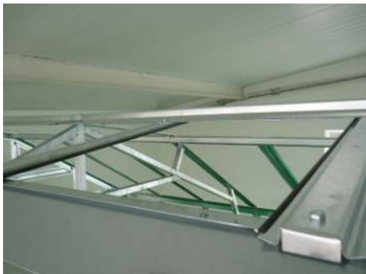
Detail zasklení hřebenové části.
