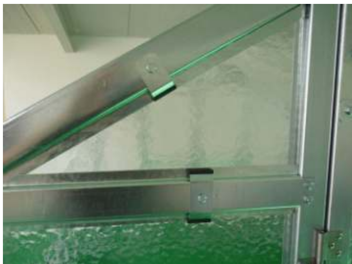
Přichycení skla k pozici 72 příchýtkou 83-1 a 83-2
