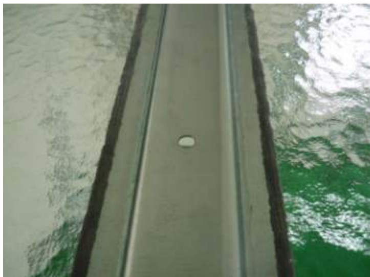
Přichycení střešního skla příchýtkou poz. 83-2. Pod tyto příchýtky můžeme zevnitř skleníku umístit vyvazovací pásky, pozice 84-2
