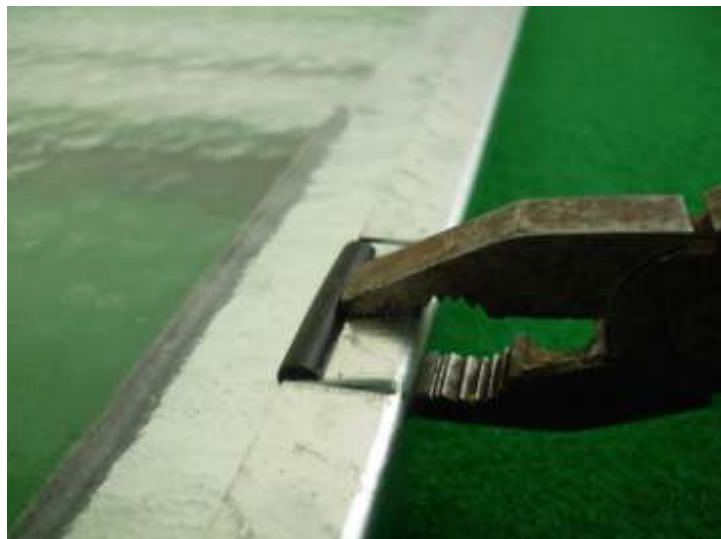
Pomocí kleští jemně přitlačíme přichytku (poz. 83-1)
