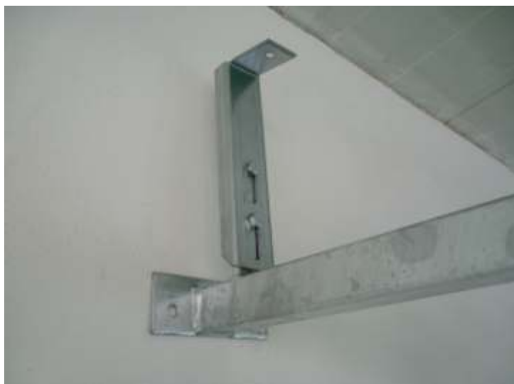
Montáž výztuhy hřebene (poz. 33) k jácklové výztuže.
