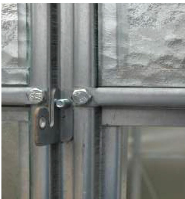
Detail umístění závěsů na sloupek čela (poz. 7).
