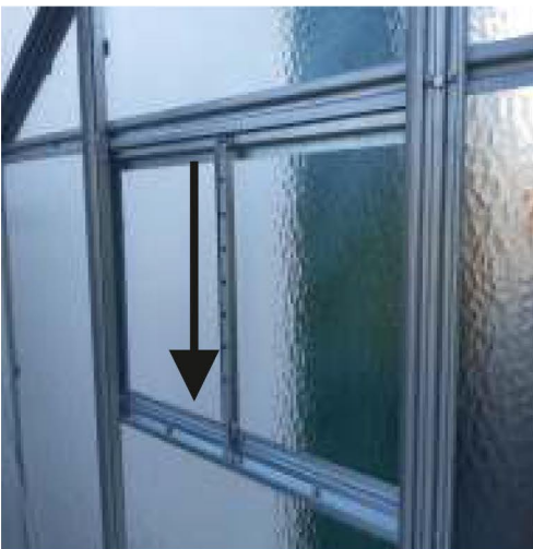
Zajistění okna - vzpěru větracího dílu, zasuněte směrem dolů. Tím je okno zajištěno.
