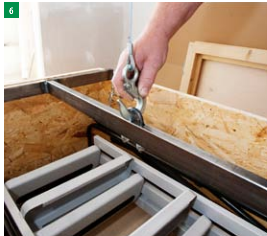
6 uchytení zvedacího zařízení – nosnost 150kg (není součástí dodávky)
