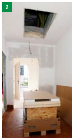
2 rozbalení stahovacích schodů ARISTO
