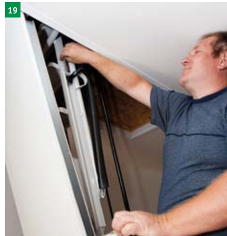
19 upravení otvírání dolního víka pomocí regulačních šroubů (horní plocha nášlapů musí být rovnoběžně s podlahou)
