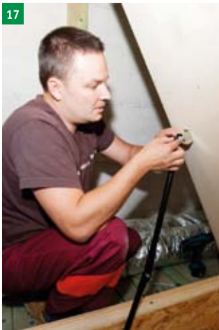
17 spojení táhel otvírání s horním víkem
