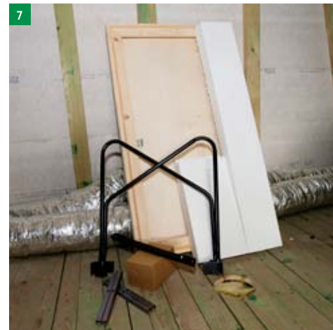
7 přemístění montážních dílů do patra
