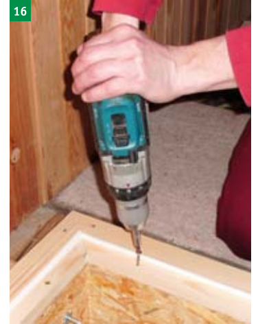
16 spojení OSB rámu s dřevěným rámem
