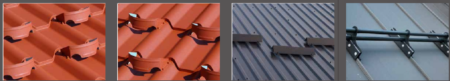
Příklady rozložení sněhových zachytávačů – obrázek č. 31
